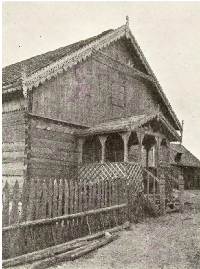
Abb. 1. Wohnhaus in Scharken, Kreis Johannisburg. Erbaut 1906.
